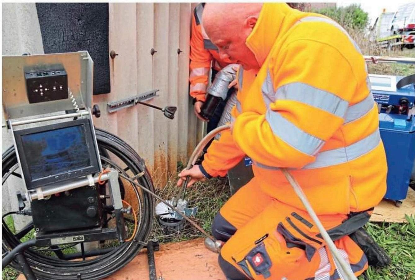
Maik Menke führt den Schleifkopf und die Spray-Bürste mit der Harz-Zuleitung in die Rohrleitung ein, per Kamera wird dann das Einsprühen der neuen Leitung überwacht.
